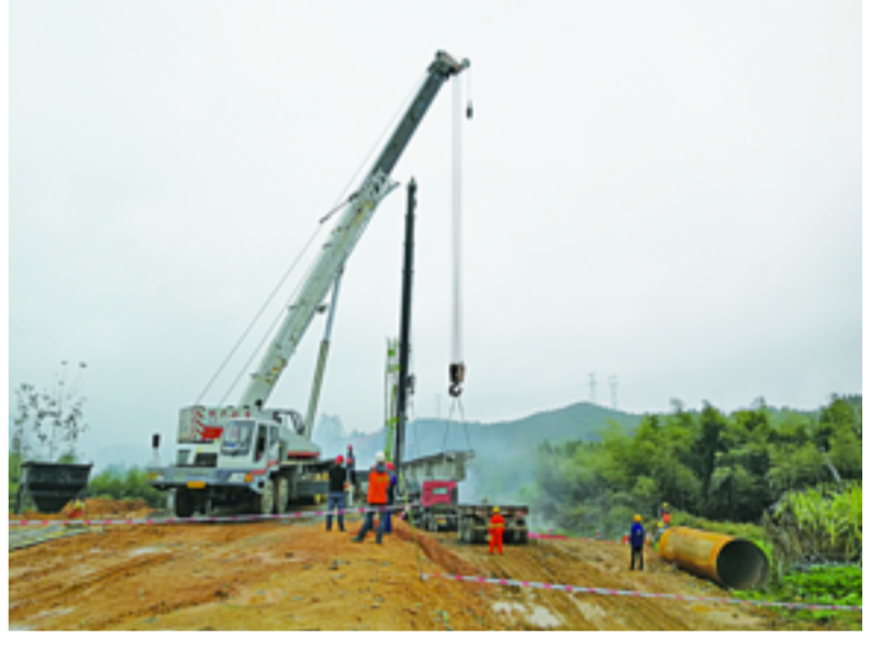
6.沿江公路施工中
